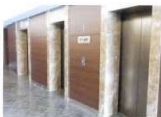
◆エレベーター◆
