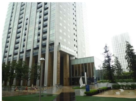
建物外観(キャピタルタワー)
