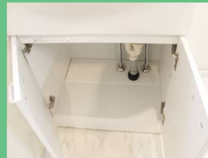
洗面収納スペース
