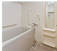
換気乾燥機付浴室
